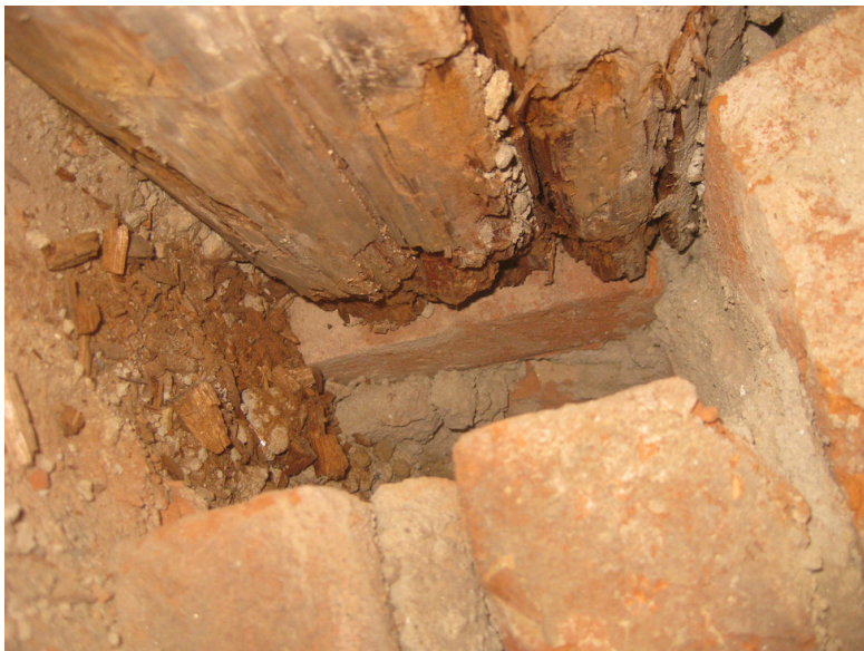
foto č.4. detail zhlaví trámu sondy S7 strop nad 2NP
