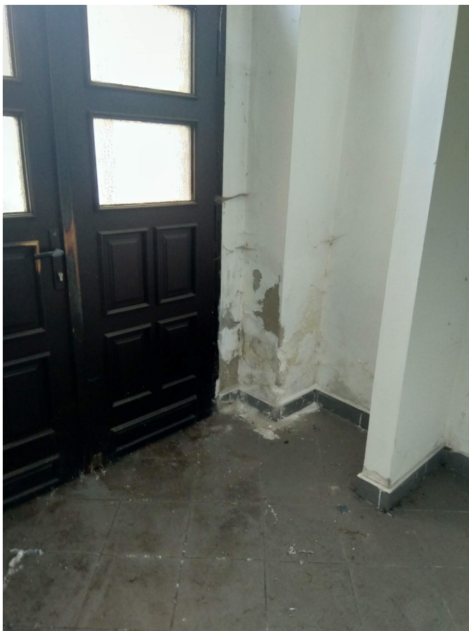
foto č.11. vlhkost vlivem zatékání - střešní světlík
