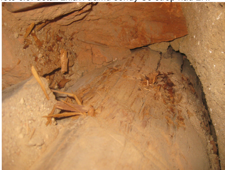
foto č.3. detail zhlaví trámu sondy S5 strop nad 2NP
