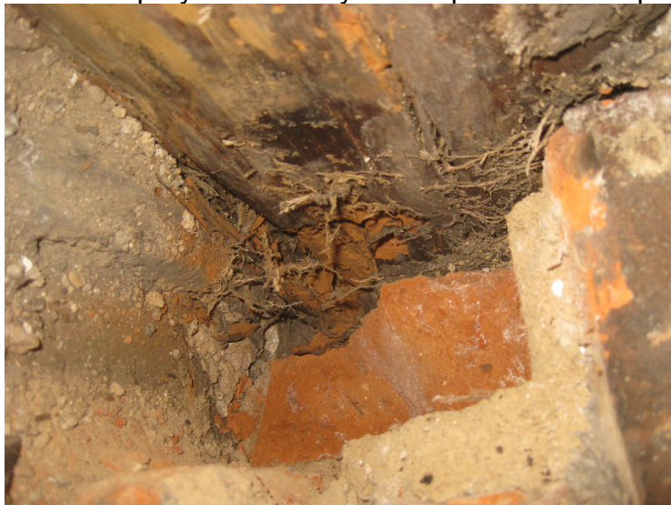
foto č.3. detail zhlaví trámu sondy S5 strop nad 2NP
