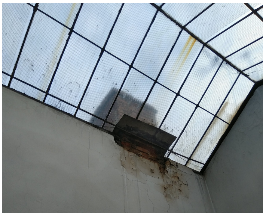
foto č.11. vlhkost vlivem zatékání - střešní světlík
