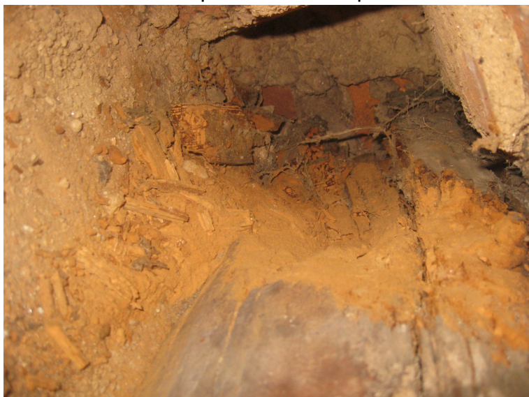
foto č.2. spóry dřevomorky na stropním trámu v podkroví
